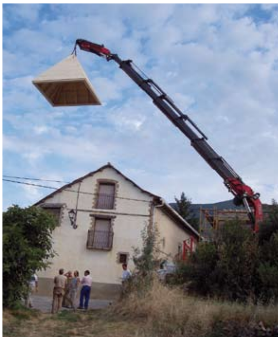
La pirámide de cubierta se hizo de una pieza en Carpintería Lacasta.
