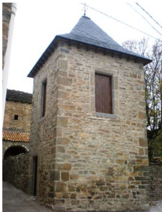
Estado final del Esconjuradero.
