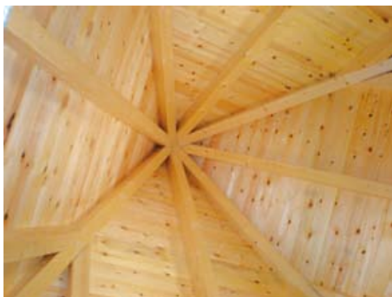
Interior de la cubierta.
